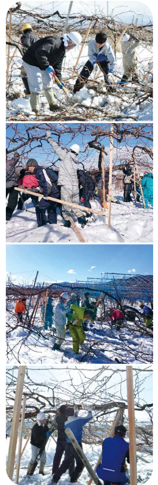
ぶどう棚復旧作業の様子
