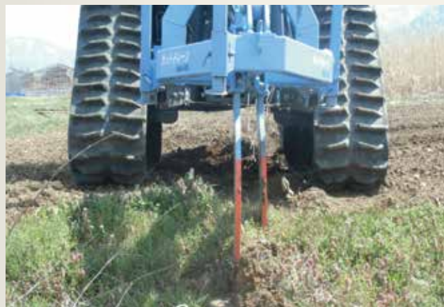
※カットドレーンによる施工
