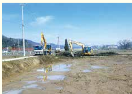
古牧地区復旧作業の様子
