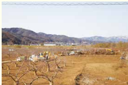
柳沢地区復旧作業の様子
