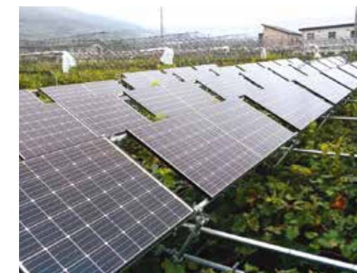
営農型太陽光発電をぶどう棚の上に設置した園地
