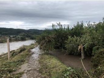
冠水被害 立ヶ花 10/14
