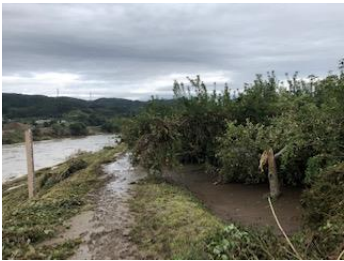
冠水被害 立ヶ花 10/14
